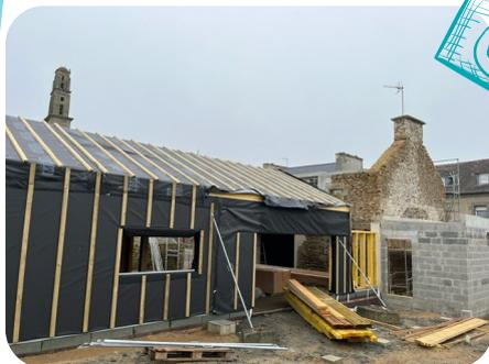
Nouvelles charpente et toiture sur l'extension ! Un échaffaudage a également été installé pour le travail de maçonnerie et d'enduit. Les raccordements électriques vont bientôt être réalisés : la circulation sera réglementée en conséquence (tranchée réalisée en travers de la route départementale). Merci de votre compréhension.
